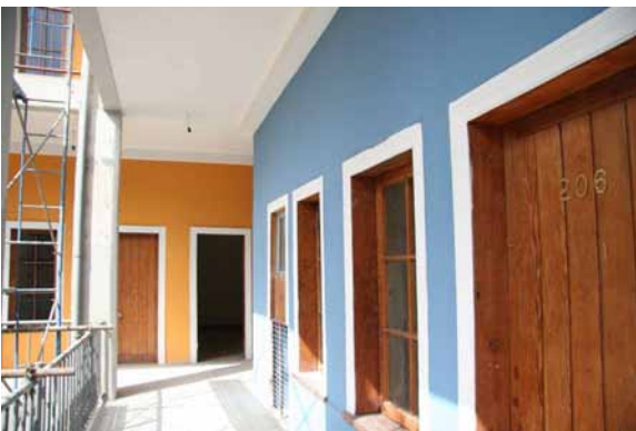
Figura 7. Pasillos de patio interior en terminaciones.
