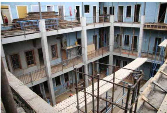
Figura 6. Patio con nueva estructura interior ejecutada.
