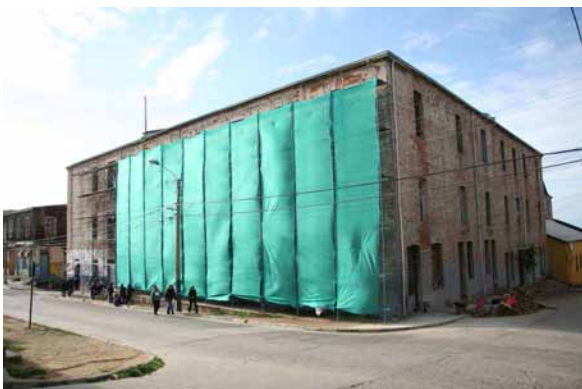
Figura 8. Trabajos en fachadas.
