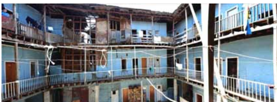
Figura 2. Detalle de fachada norte de patio interior, situación original.
