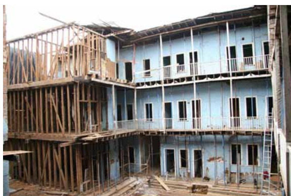
Figura 4. Desarme de zona norte.
