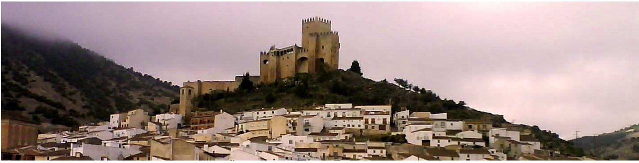
Fig. 3. Palacio-Fortaleza de Vélez Blanco. Construido en el S. XVI sobre el alcázar musulmán.
