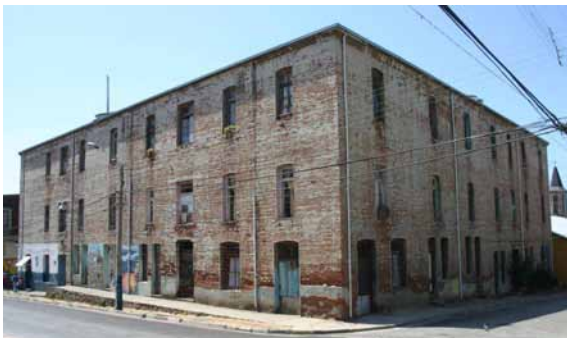
Figura 1. Fachada esquina Eyzaquirre con Camino Cintura, situación original.
