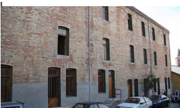
Figura 9. Fachada oriente terminada.
