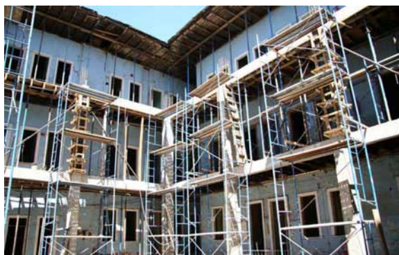
Figura 5. Ejecución de nueva estructura de hormigón armado en patio.
